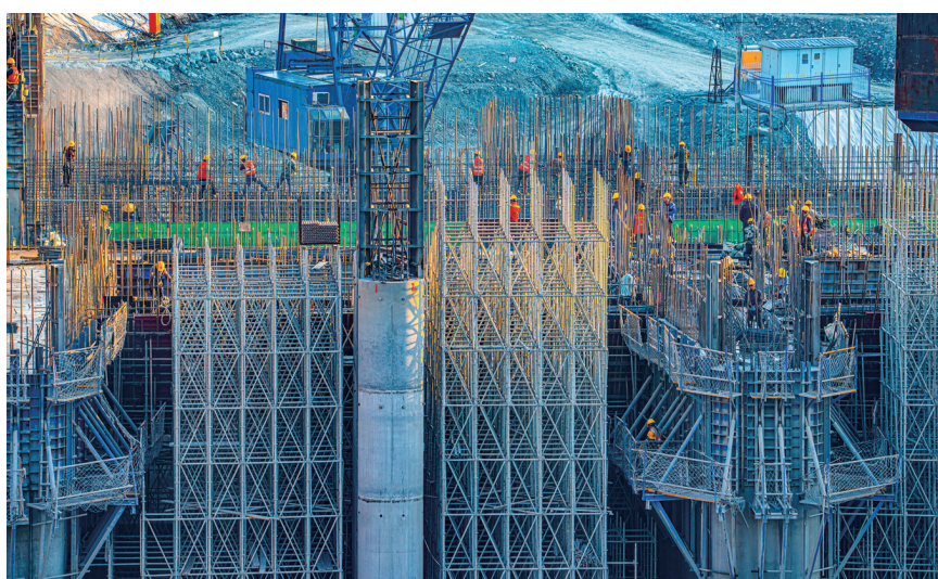
▲ 银江水电站筑坝工程 摄影 / 周毅
