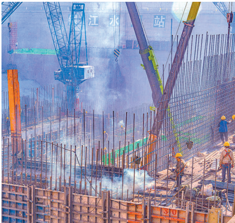
沸腾的工地 周毅/摄
