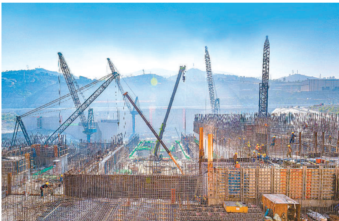
银江水电站施工现场 周毅/摄
