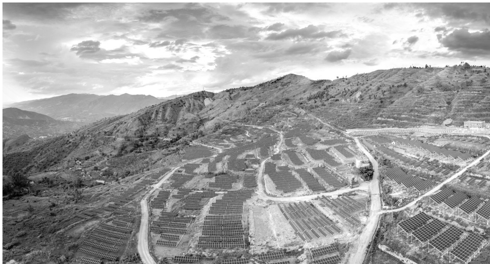
物产公司光伏发电
