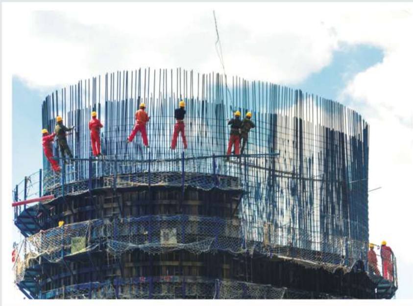
▲ 钢筋铁骨 摄影 / 雷建萍
